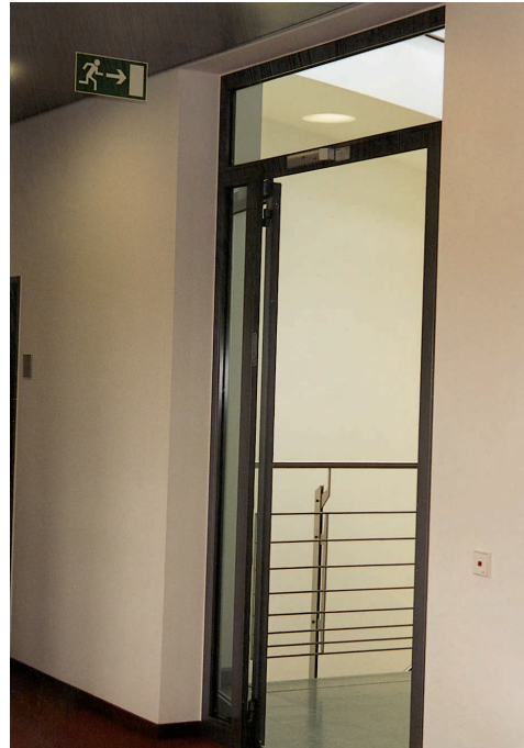
Abb. 4.6.5/27: Beispiel eines schlecht erkennbaren Fluchtwegpfeils, da sehr hoch angebracht und nicht beleuchtet (Quelle: Scelsi)
